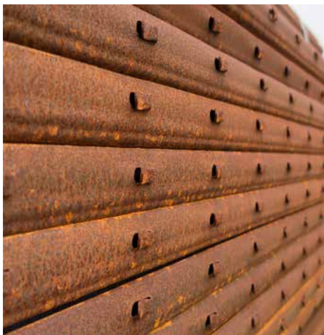
Pali 55x35 con ganci esterni - processo di ossidazione avanzato
